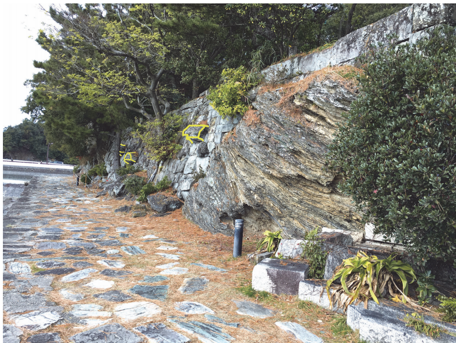
図4：多宝塔の敷地を造成する石積みから突出する3つの石（黄線筆者）
