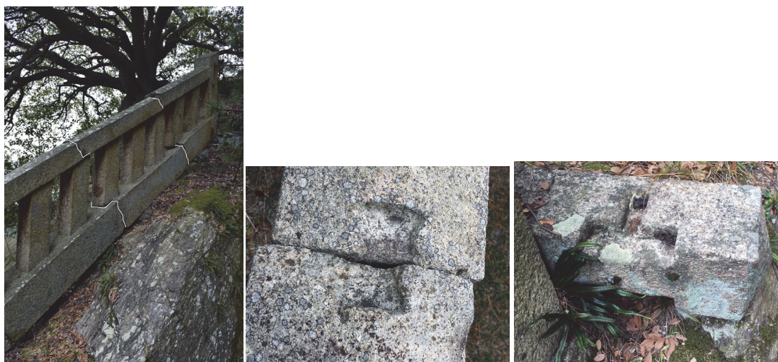
図5：多宝塔の石柵 左；組み方（白線筆者） 中；笠木天端錠の痕跡 右；地覆の仕口痕
