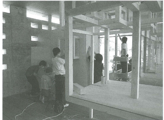
写真3 カフェ組み立て作業の様子
