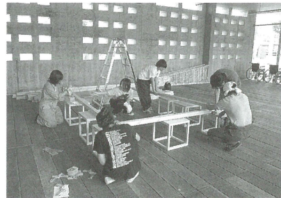
写真2 「アーチの森」の立方体ユニット施工の様子
