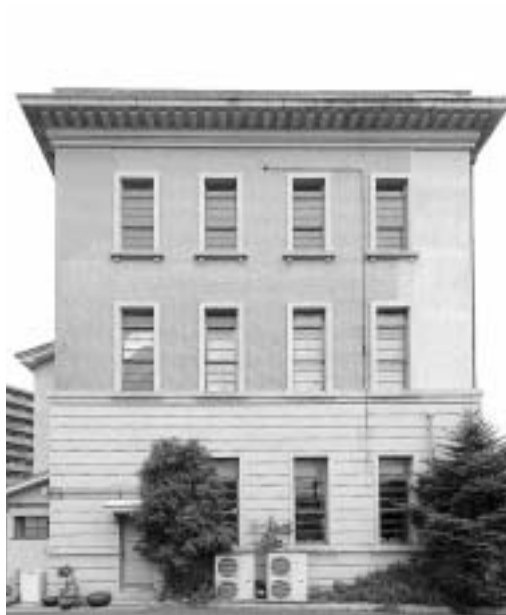
図6：旧西本組本社ビル南面
