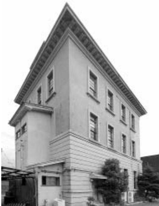
図7：南西から見た旧西本組本社ビル
