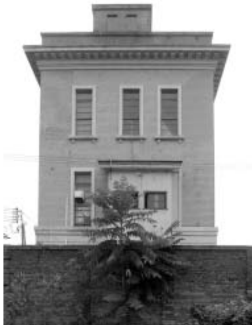
図8：旧西本組本社ビル西面
