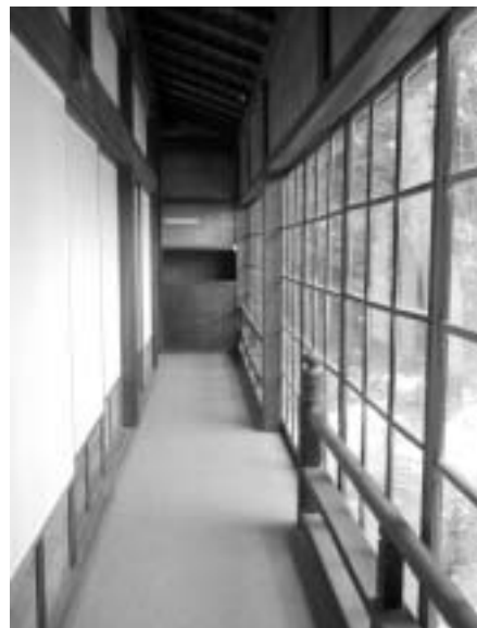
図16：(3) 奥座敷の西側廊下
