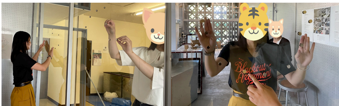
図22 ガラス扉の衝突防止マーク
