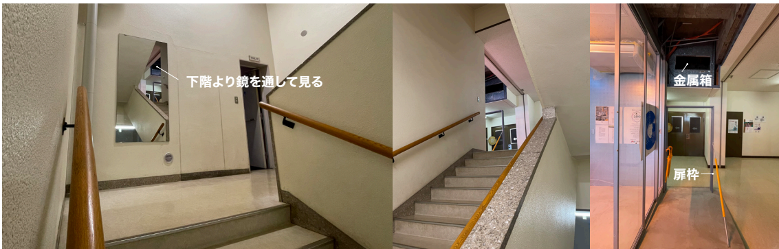
図23 空調ダクトでデータアート(制作予定場所)
