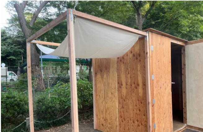
写真7：両側に設置された「ひさし・ユニット」の様子
