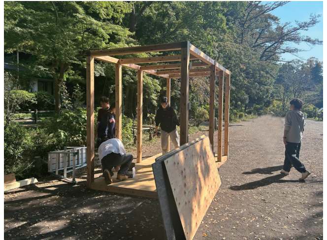
写真5：組み立て作業時の様子
