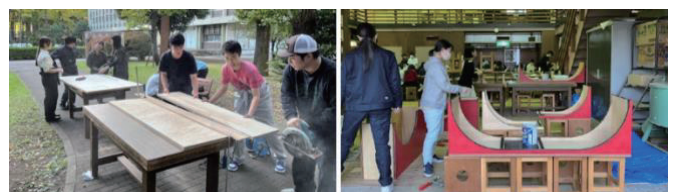
図 5 自主施工の様子
