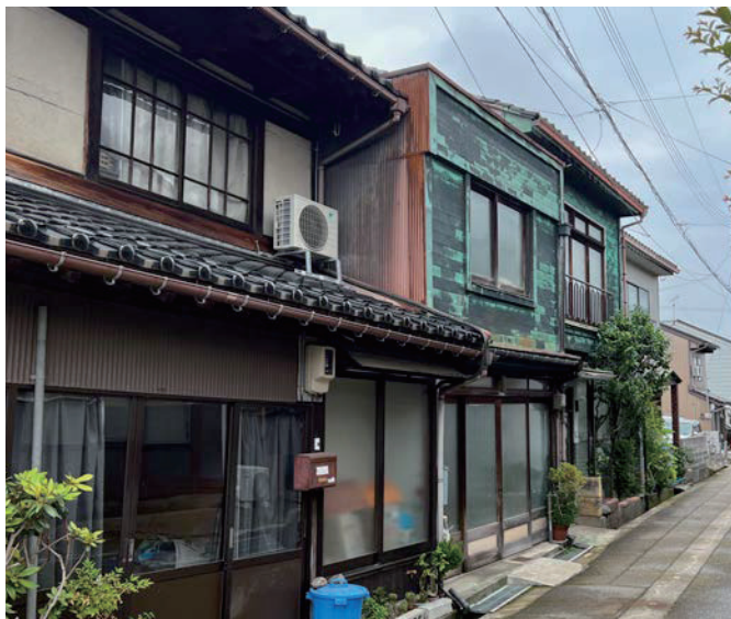
写真7 川原町の銅板張り家屋 (2023.8 撮影)
