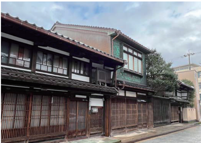
写真3 金屋町の銅板張り家屋 (2023.12 撮影)
