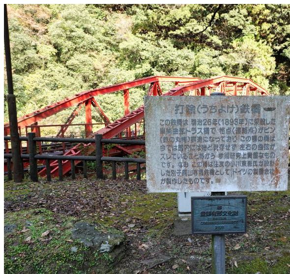
(図8) マイントピア別子・端出場ゾーン内にある旧別子鉱山鉄道端出場鉄橋の解説板。同鉄橋は上述の通り鉱山観光列車の路線として活用されているため、メンテナンスの必要がある。解説板の下に登録有形文化財であることを示す銅板プレートが取り付けられている。2021年11月撮影。
