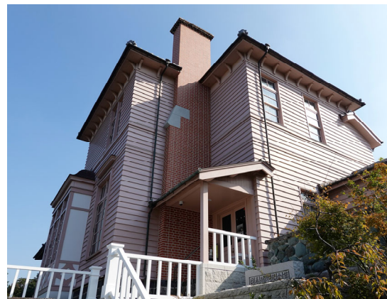
（図4）日暮別邸記念館。四阪島の立地に似せた高台上に移築されている。外壁・窓・屋根などは老朽化のため、また柱や梁は耐震性の関係から新規素材となっているが、内部は当初の建材により忠実に再現されている。2021年11月撮影。
