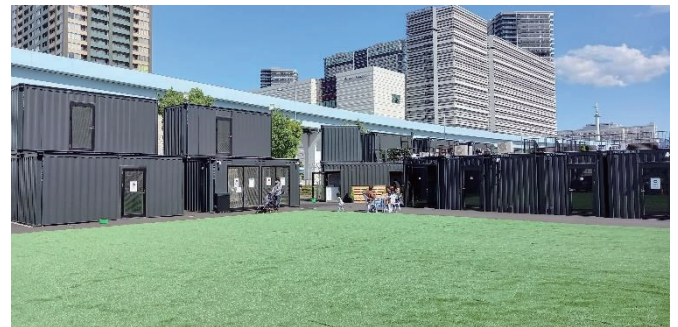
図2 プロジェクト実施前の施設の様子
