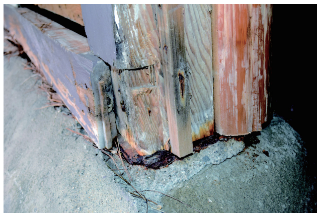
図4：柱脚の鉄板
