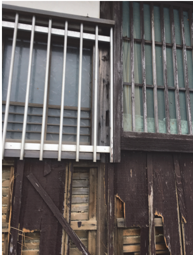
図 12：座敷と洋間の境の柱外面の仕口
