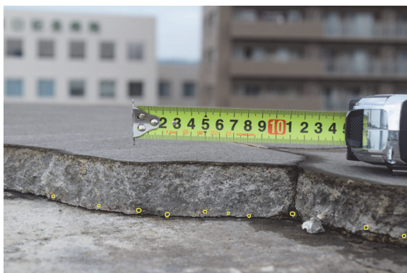
図 3：(左) 防水モルタル層下部に丸鋼の断面が見える、(右) ペントハウス東面
