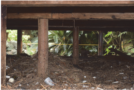
図 10：素通しになった座敷部床下に見える床束
