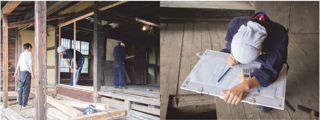
写真10. 座敷の改修作業（2017年）
