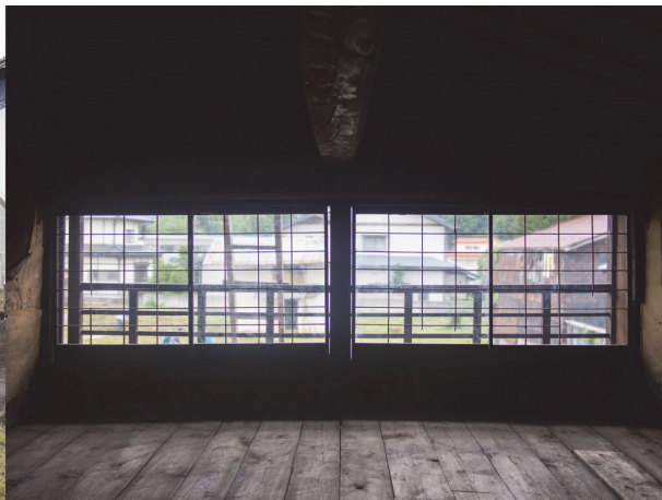
写真16. 座敷2階（実測と並行した原状回復作業後の様子）
