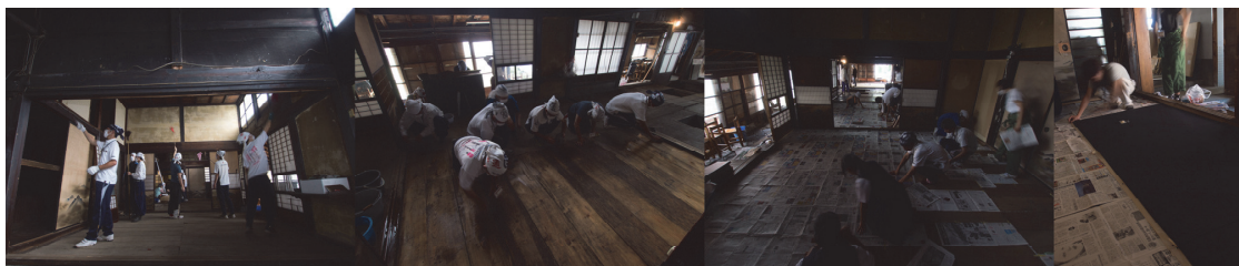
写真 22, 写真 23, 写真 24, 写真 25. 住居部分の掃除と床張りの作業
