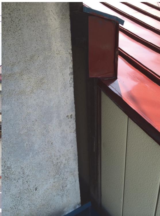
写真 13. 隣家の外壁部分（三田屋のもとの内壁が見える）
