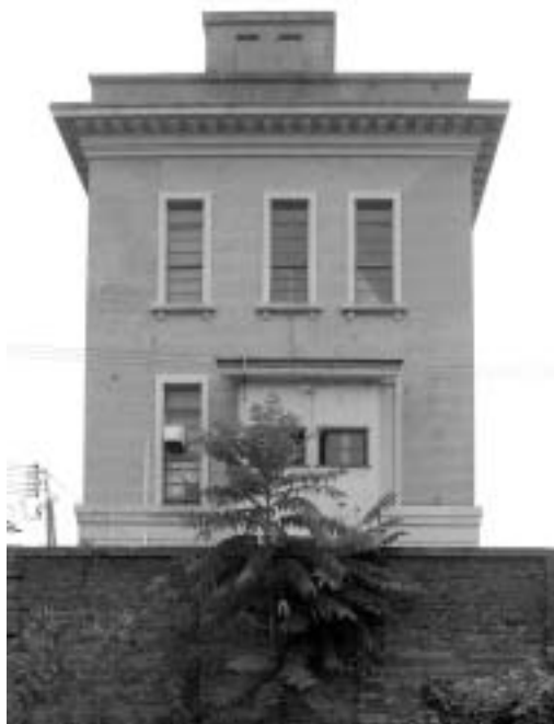
図8：旧西本組本社ビル西面
