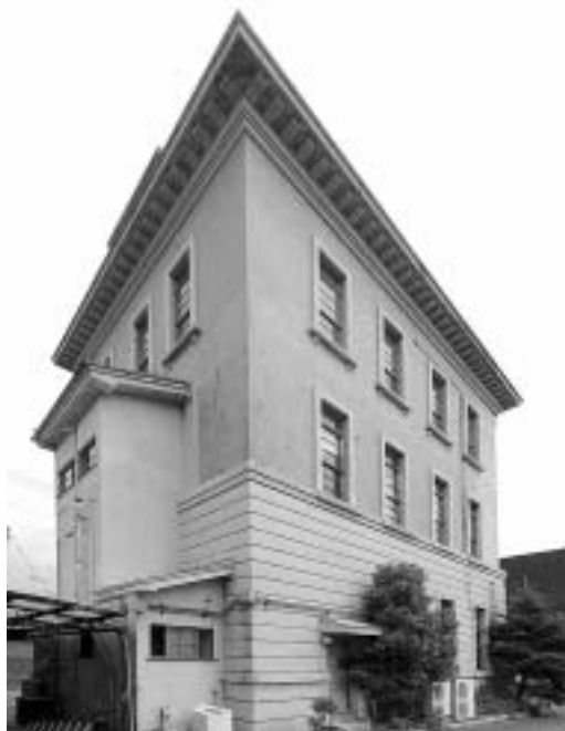
図7：南西から見た旧西本組本社ビル
