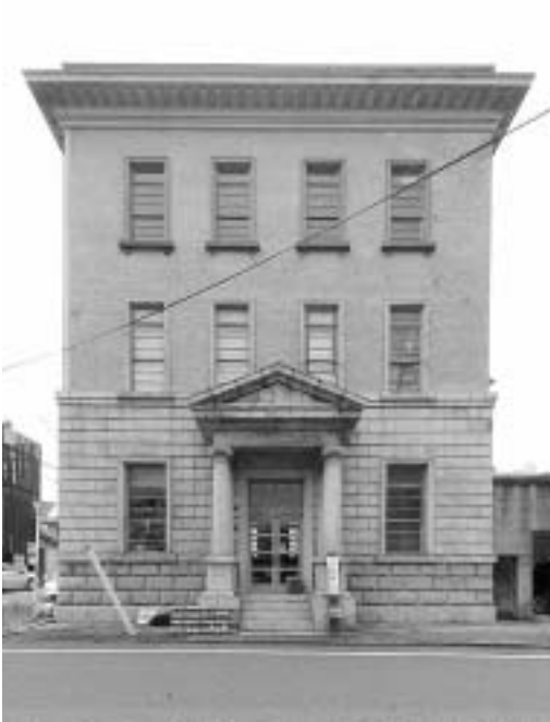
図 1：旧西本組本社ビル北側正面
