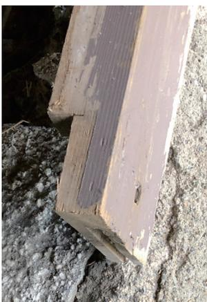
図 2：床下木部表面のペンキ塗り仕上げ
